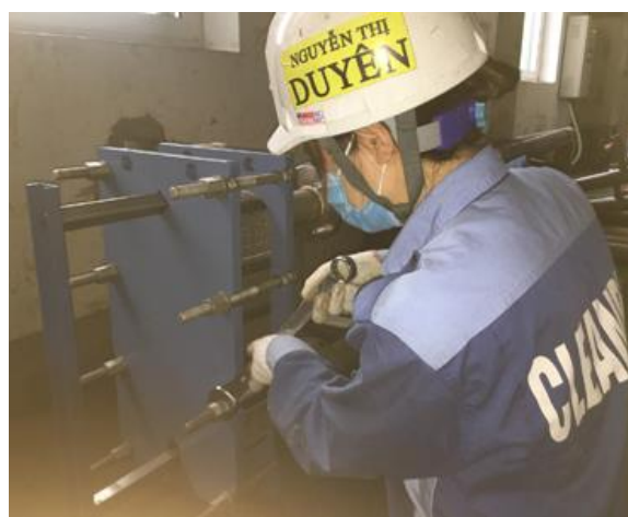
Thay gioăng tấm thiết bị trao đổi nhiệt ITT
