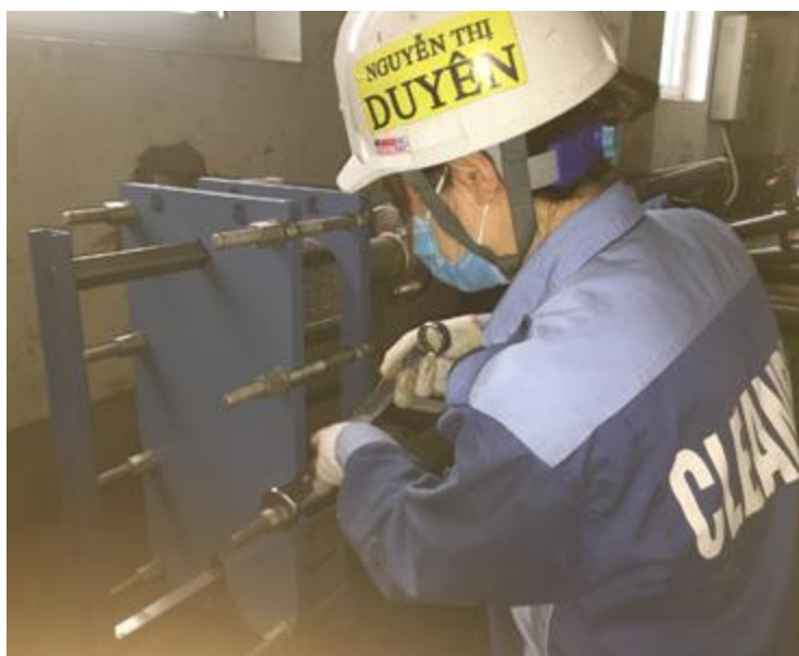
Thay gioăng tấm thiết bị trao đổi nhiệt GEA
