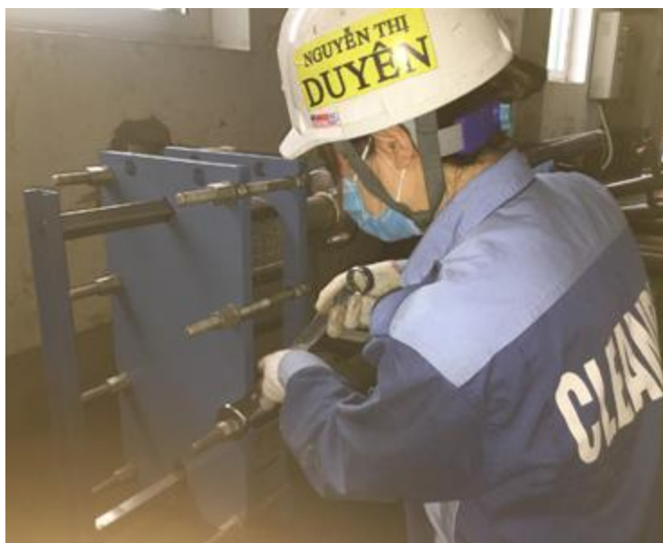
Thay gioăng tấm thiết bị trao đổi nhiệt FUNKE
