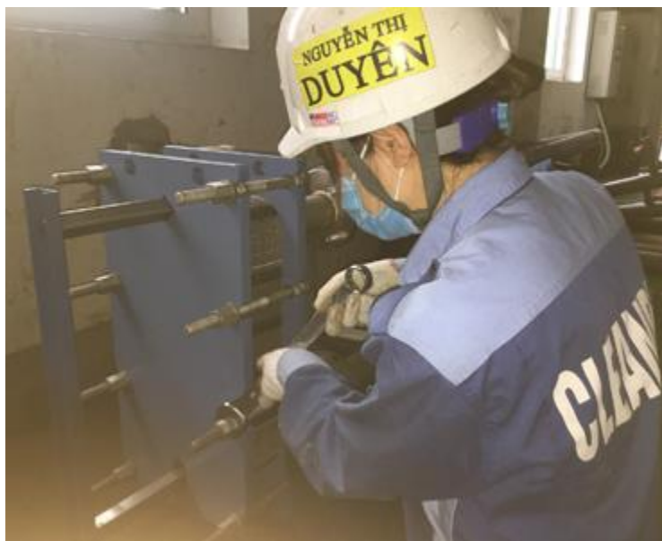
Thay gioăng tấm thiết bị trao đổi nhiệt APV PASILAC
