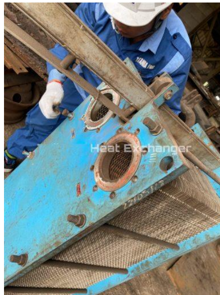
Thay gioăng tấm thiết bị trao đổi nhiệt APV heat exchanger
